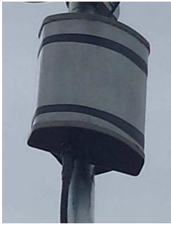
Fig 16. Antena de sectorial de 9dBi de ganancia
