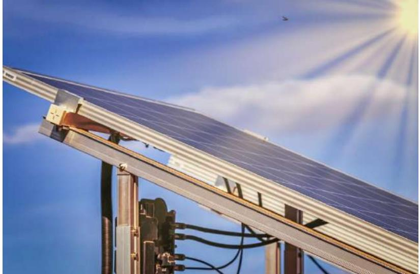
La presente invención comprende una estructura solar modular que permite integrar estructuralmente un módulo fotovoltaico y/o un intercambiador de calor mediante un soporte plano y/o corrugado y un soporte para cierre hermético, asimismo, también permite integrar estructuralmente un dispositivo de seguimiento solar, mediante el soporte de acoplamiento y giro, y el soporte para módulo fotovoltaico.
